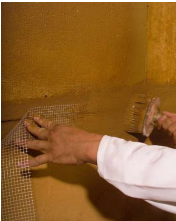
Abbildung 5.3.3: Einarbeiten der Fugenarmierung, hier Glasseidgewebe
