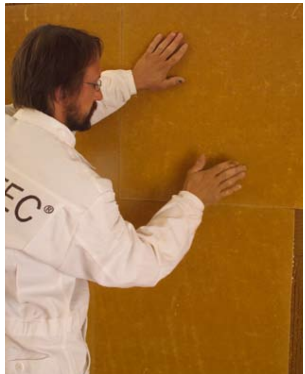
Abbildung 5.3.2: Ansetzen der Lehm-Trockenputzplatten D16 in den feuchten Feinputz
