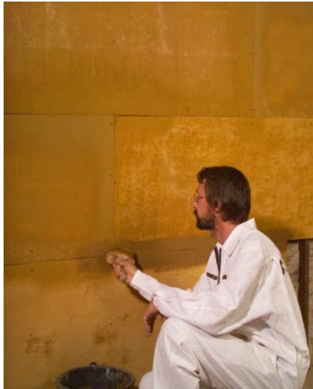
Abbildung 5.2.5: Vorziehen der Schlämme aus Claytec Lehm-Oberputz fein
