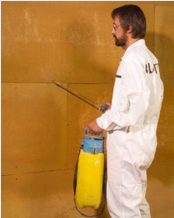
Abbildung 5.2.4: Vornässen der Fugenbereiche der Lehm- bauplatten
