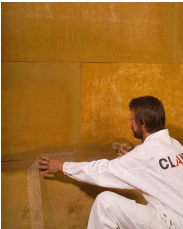
Abbildung 5.2.6: Einarbeiten der Fugenarmierung, hier Glasseidengewebe
