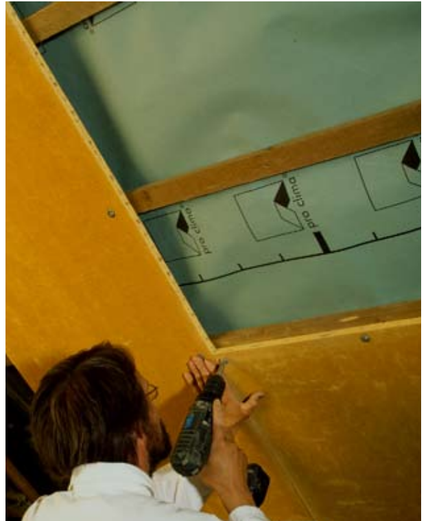
Abbildung 5.2.2: Montage der Lehmbauplatten an einer Dachschräge mit Verlattung
