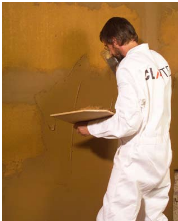
Abbildung 5.2.7: Überspachteln der gesamten Fläche mit Claytec Lehm-Oberputz fein nach abermaligem Vornässen
